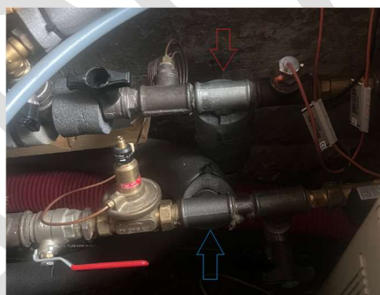
Billede 5 Efter tilslutning til veksler
