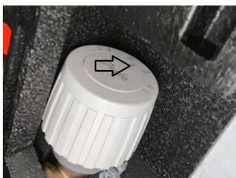
Billede 8, retur termostat for justering af returvands temperatur i tomgangsdrift.
