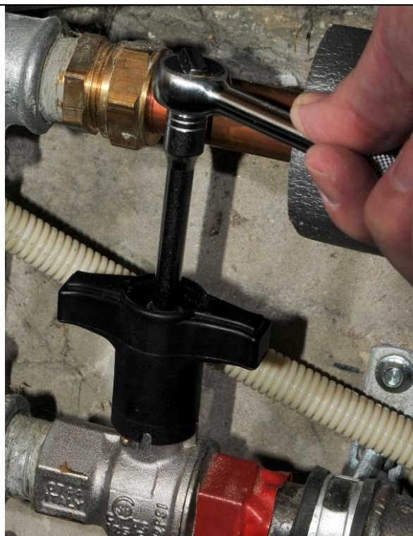
7. Herefter kan en lille skrue i bunden af håndtaget løsnes med en 7 mm topnøgle.
